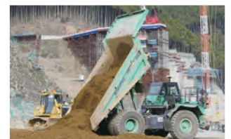
自動ダンプトラックと自動ブルドーザの連携 Cooperative work of automated dump truck and bulldozer
